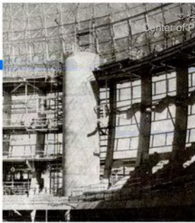
جانب من المدرجات حيث تظهر أبراج السلاسل الاسطوانية الموزعة على محيط الهيكل الرئيسي كما يظهر التغليف الفارغى لسقف الكرة.
