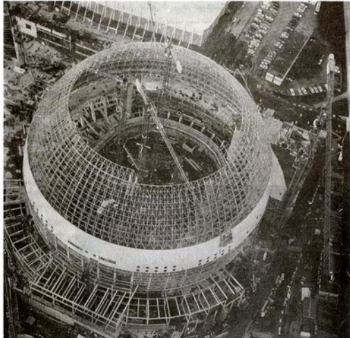
الهيكل المعدنى المنشا وقد استخدم فيه حوالى ٢٥٠٠ طن من الصلب استمر العمل بالموقع ليل نهار من توقف لتنفيذ أضخم مشروع إنشائى من نوعه يبلغ قطره الداخلى ١١٠م وارتفاعه الداخلى ٨٥ متر. ↓
