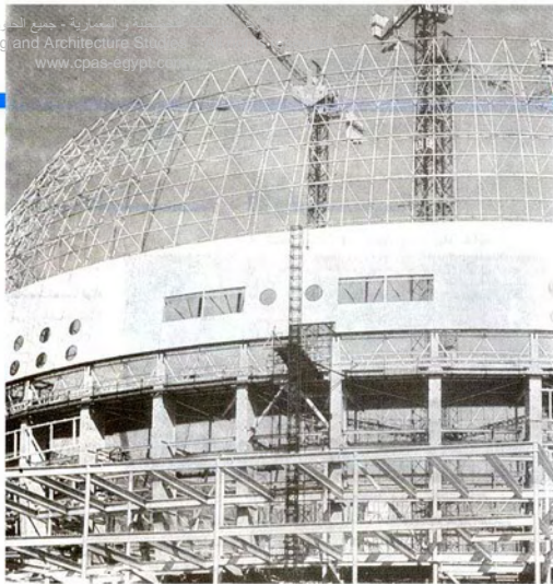
الهيكل المعدنى المنشا وقد استخدم فيه حوالى ٢٥٠٠ طن من الصلب استمر العمل بالموقع ليل نهار من توقف لتنفيذ أضخم مشروع إنشائى من نوعه يبلغ قطره الداخلى ١١٠م وارتفاعه الداخلى ٨٥ متر. ↓
