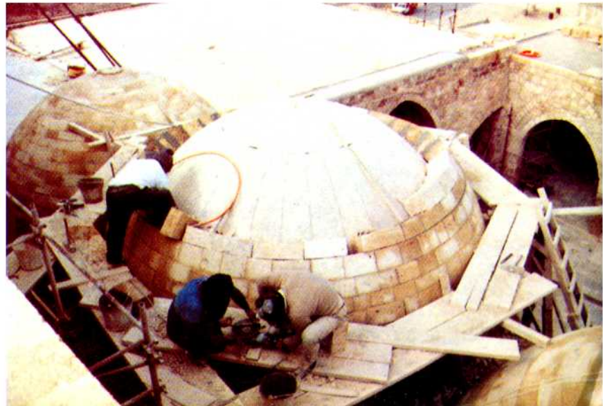
● القبة أثناء إعادة الانشاء .
