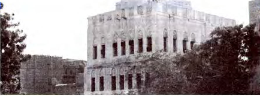
● العمارة اليمنية الأصيله في مبنى حكومي أو مسكن أو مآذنه الجامع حيث تتلاحم العمارة الدينية والديناويه من خلال الطابع المعماري اليمني الأصيل .
