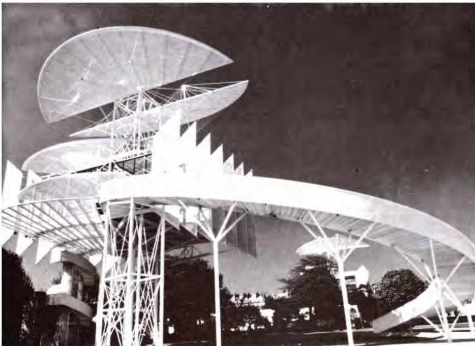
صورة لبرجى الحرية بعد التشييد
