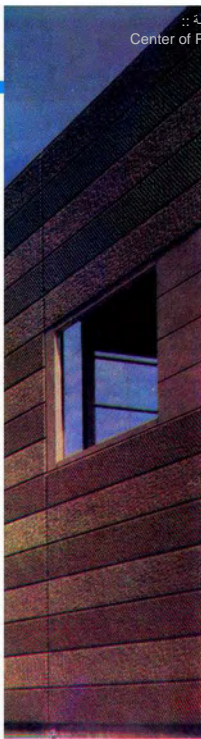
● استخدام وحدات الخرسانة السابقة الصب ذات الأسطح الناعمة عند الفتحات .
