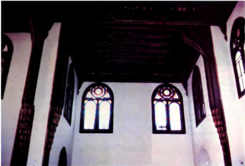
✦ سقف الخشب والشبابيك الزجاجية بعد الترميم .
