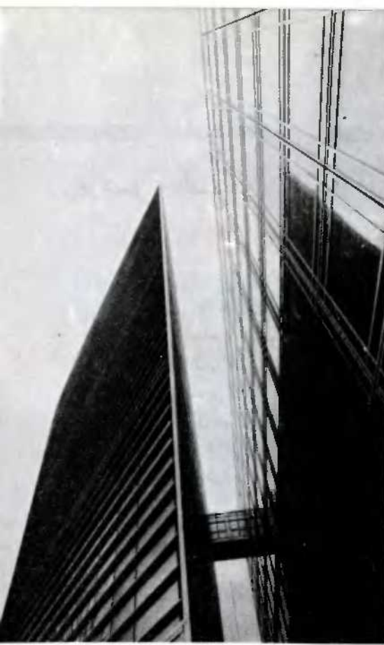
برجى المبنى يتصلان بواسطة الاقفاق الزجاجية .
