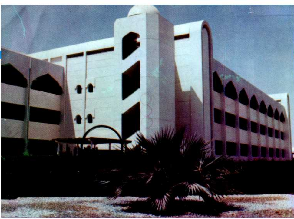
جانب من مبنى المستشفى وتظهر فيه عناصر الاتصال الرأسية .
