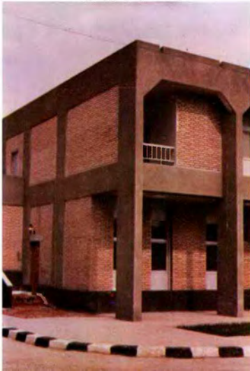
مبنى الضيافة جزء من الواجهة الرئيسية .
