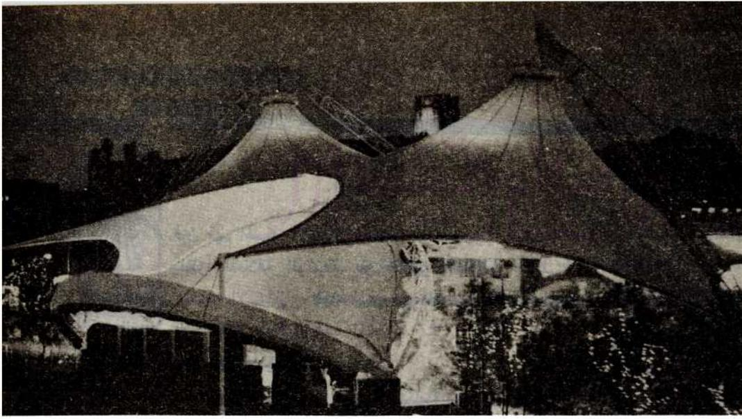
▶ يستخدم في هذا المنشأ الهياكل على شكل حرف (A) وكوابيل التثبيت الخارجية بالإضافة إلى نظام السقف الاشعاعي لتكوين الاشكال الغشائية .
