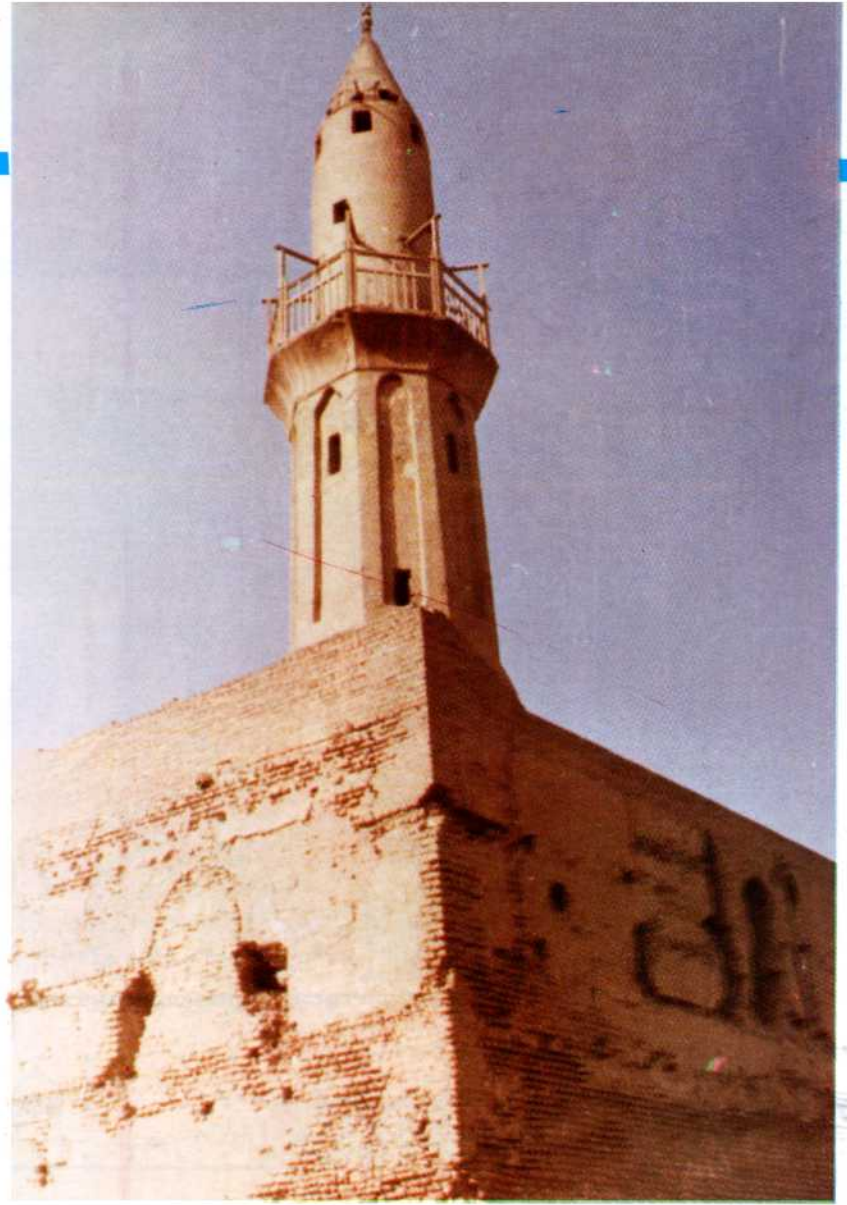
المشذة الجنوبية قبل الترميم .
