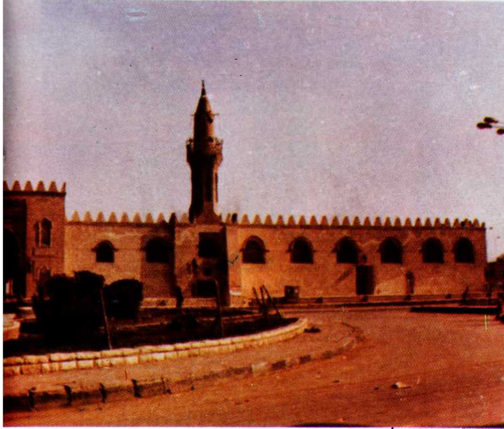
الواجهة الشمالية الغربية أثناء الترميم .
