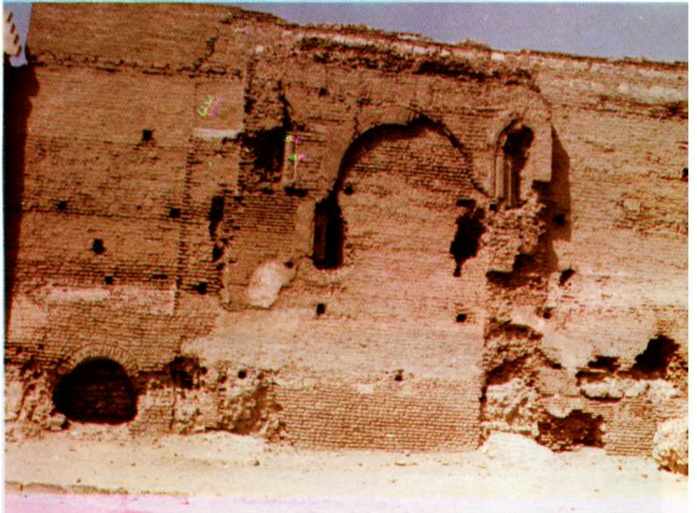
الواجهة الجنوبية الشرقية قبل الترميم .
