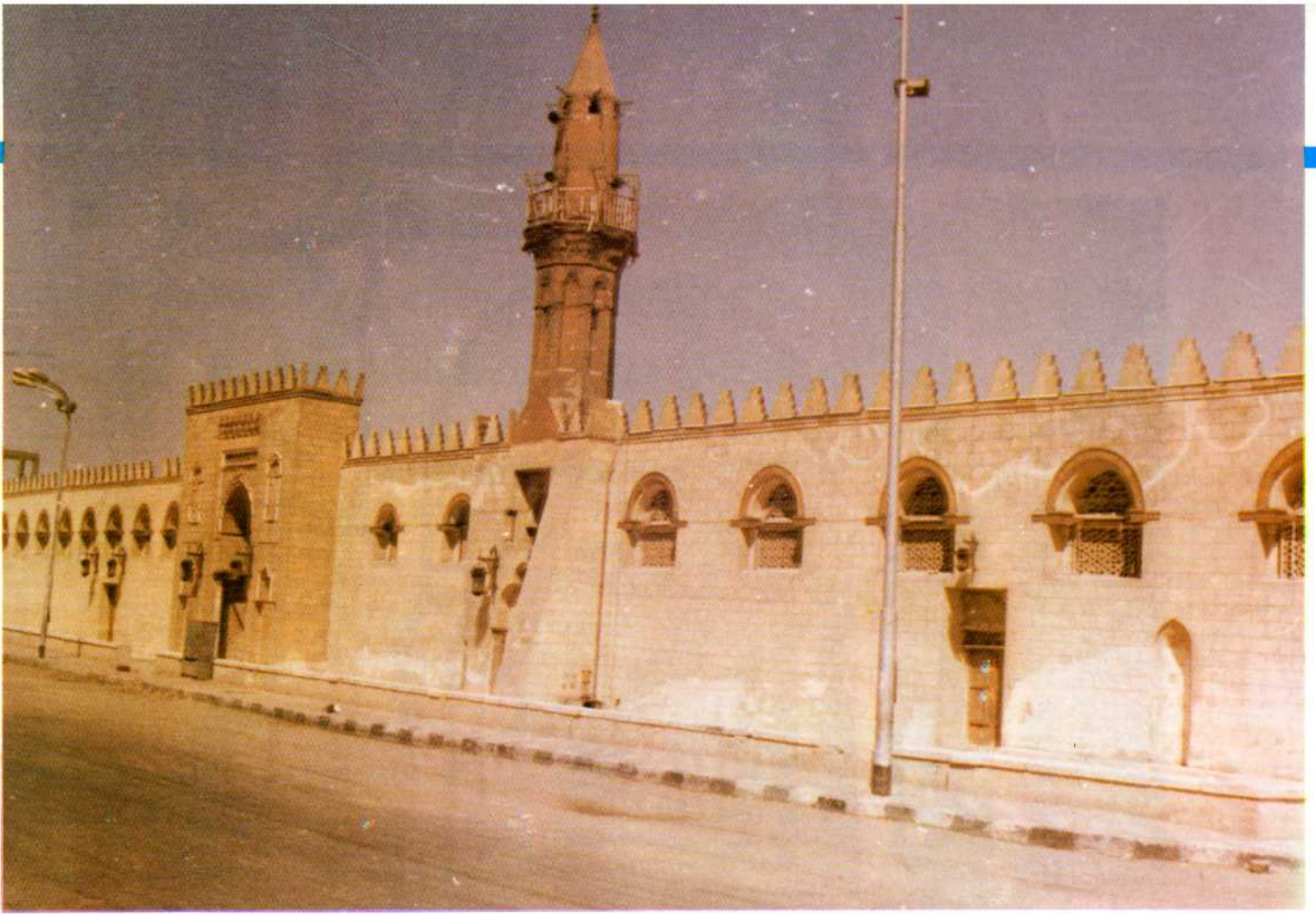
الواجهة الشمالية الغربية قبل الترميم .
