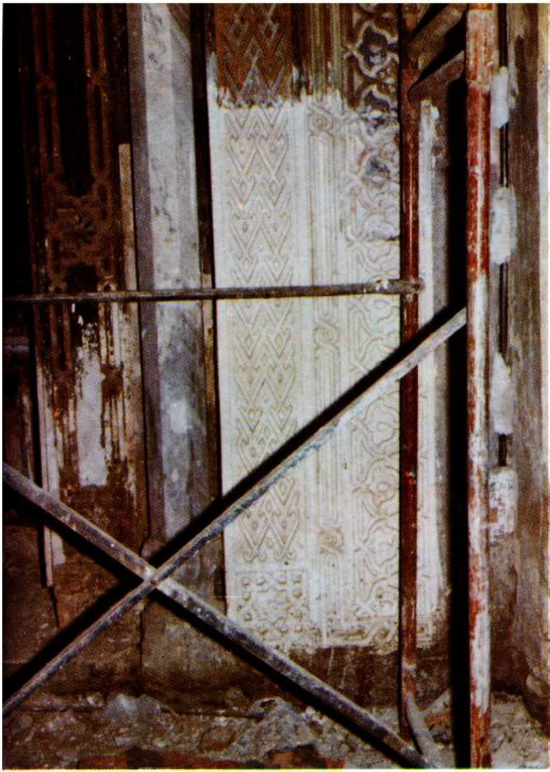
أعمال الترميم بالمغرب .
