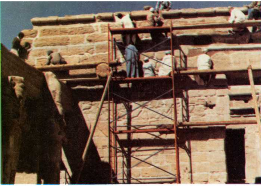
• أعمال الترميم بالصرح الثانى
