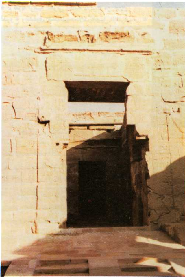
● واجهة الفناء الأول بعد الترميم
