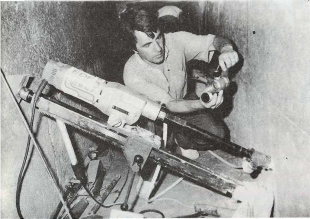
• جهاز الثقب الذى صمم خصيصاً لأبحاث الهرم الأكبر
