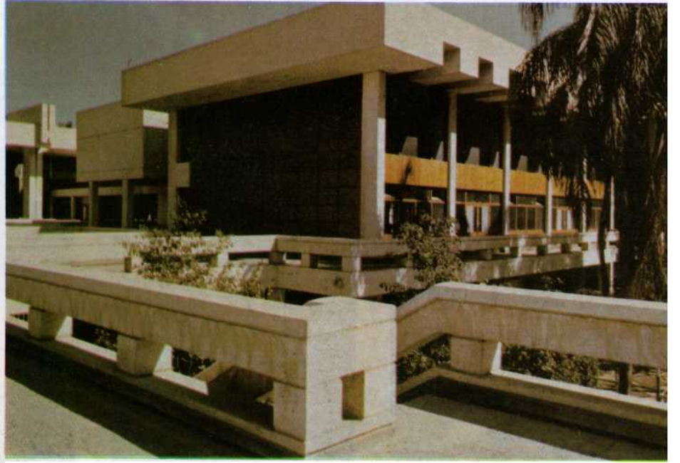
مبنى اتحاد طلبة كلية الهندسة جامعة القاهرة .
