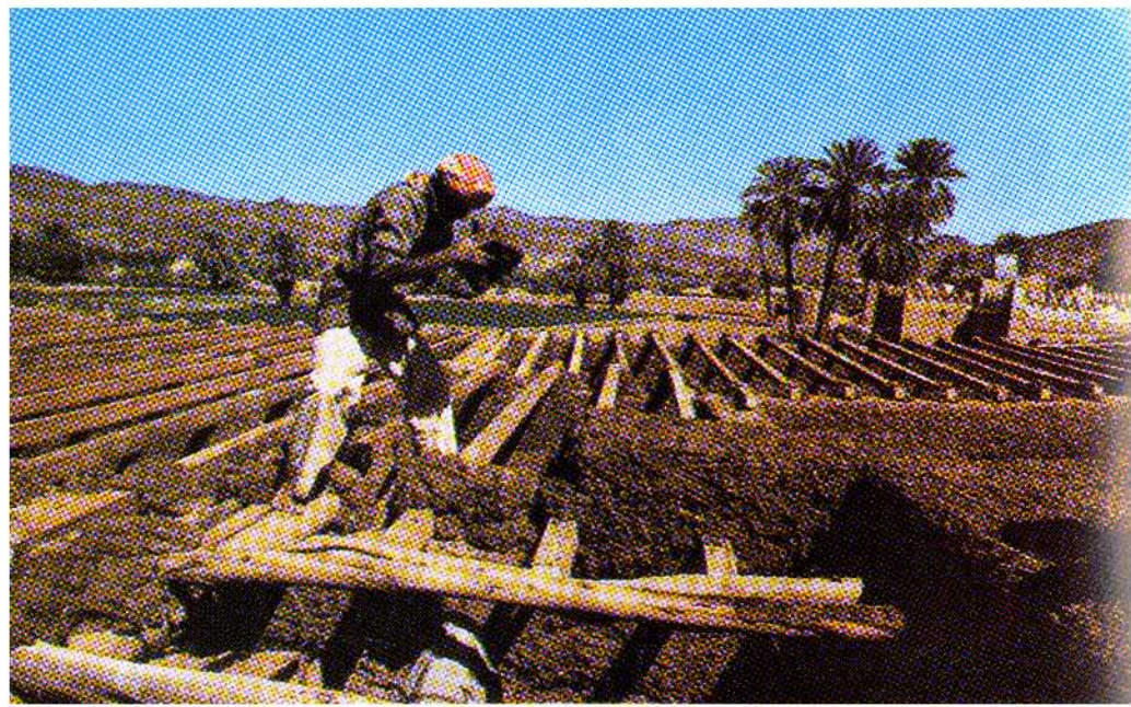
استخدام الطين وسعف النخيل لبناء حوافط أحد المنازل تحت الانشاء .
