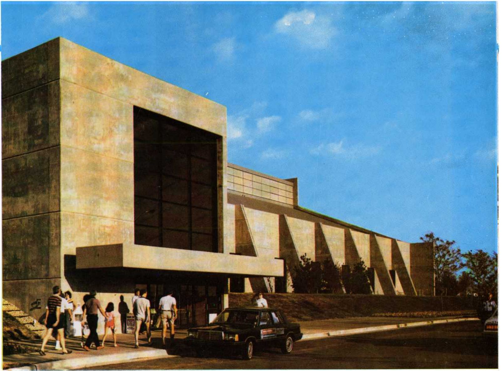
● جانب من مبنى اجمع الرياضى من جهة المدخل ويظهر فيه الدعامات البارزة
