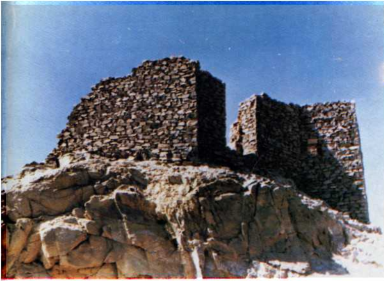
المدخل الرئيسي للتحصين من الداخل قبل الترميم .
