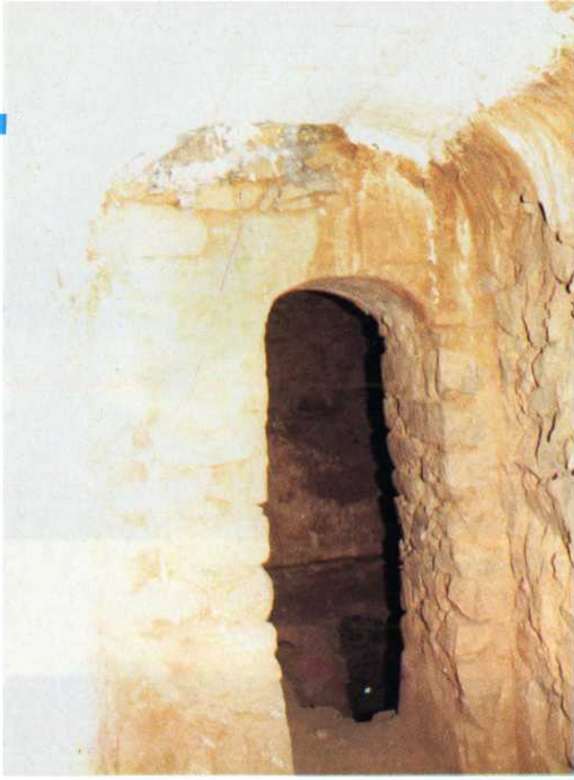
الحجره الدافئه بمجموعه الحمام بعد الترميم .
