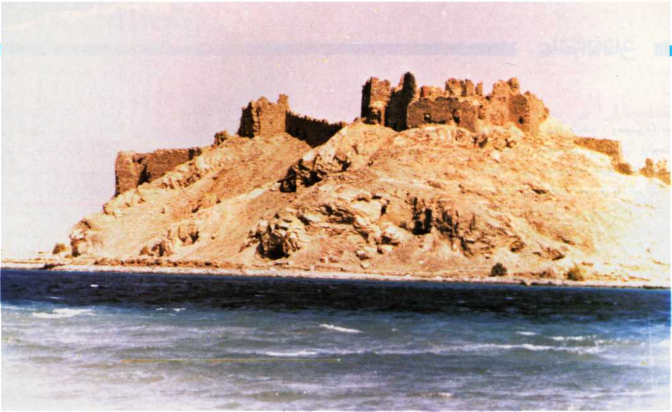
الواجهة الشمالية للتحصين الشمالي ويظهر السلم المؤدى إلى المدخل الرئيسى قبل الترميم .
