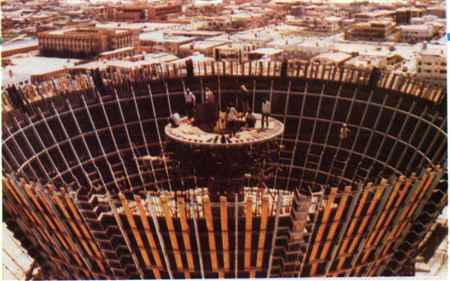
استخدام الهياكل المؤقتة في عملية تنفيذ خزان مياة في المملكة العربية السعودية - يبلغ ارتفاعه ٤٨ متراً ، ويحتاج هذا العمل الى دراسة أدق التفاصيل .
