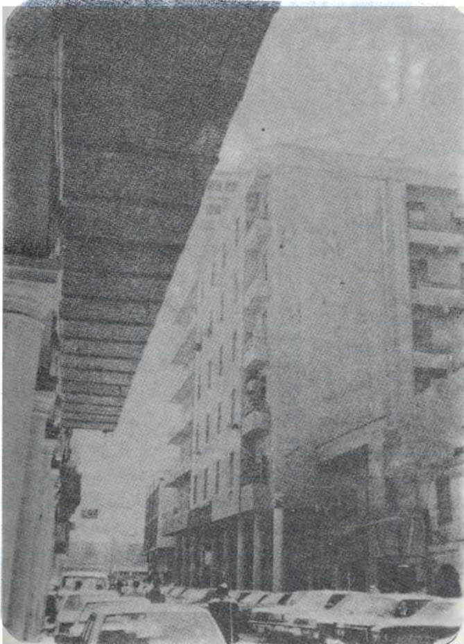
عمارة الدامرجي - ١٩٤٨ من أعمال المماري نيازي فتو
