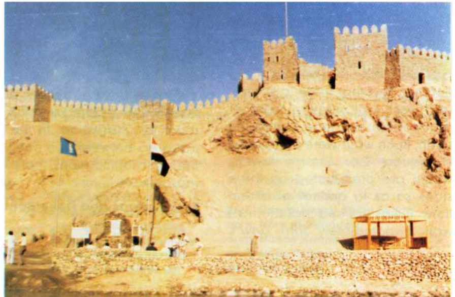
جزء من السور الغربى للتحصين الشمالى قبل الترميم وتظهر بقايا الشرفات .
