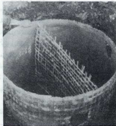
في إندونيسيا أيضاً أنشئت خزانات تحليل من غرفتين باستخدام أسلوب التسليح بالبامبو .
