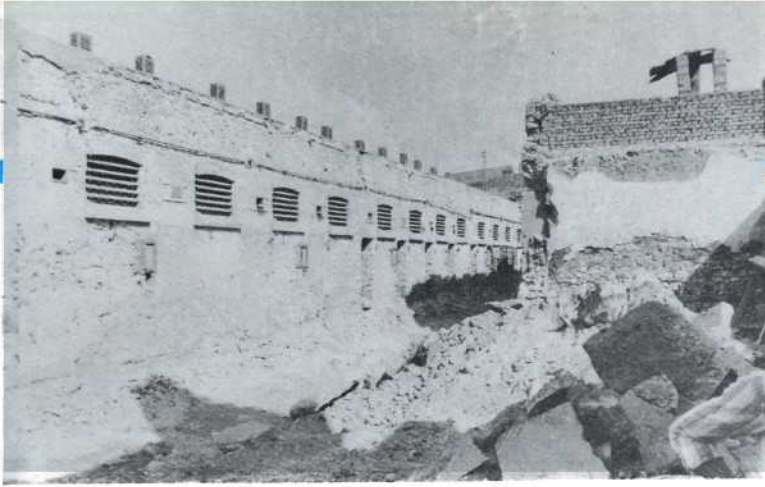
أعمال التنظيف والترميم بساحة العلم وسجن القلعة .
