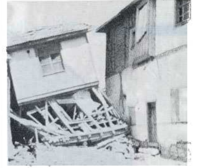
حتى إذا كان المنشأ نفسه صامد أمام الزلازل ، فقد تتعرض العناصر غير الإنشائية للانهيار مثل هذه الحوائط المبنية من الطوب والتي انهارت أثناء زلزال هاينشج ١٩٧٥ م .
