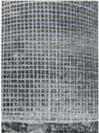
التسليح بالبامبو في الموضع الملائم لبناء: خزان تجميع مياه المطر والمستعمل فيه مادة الفيروسمنت باندونيسيا .
