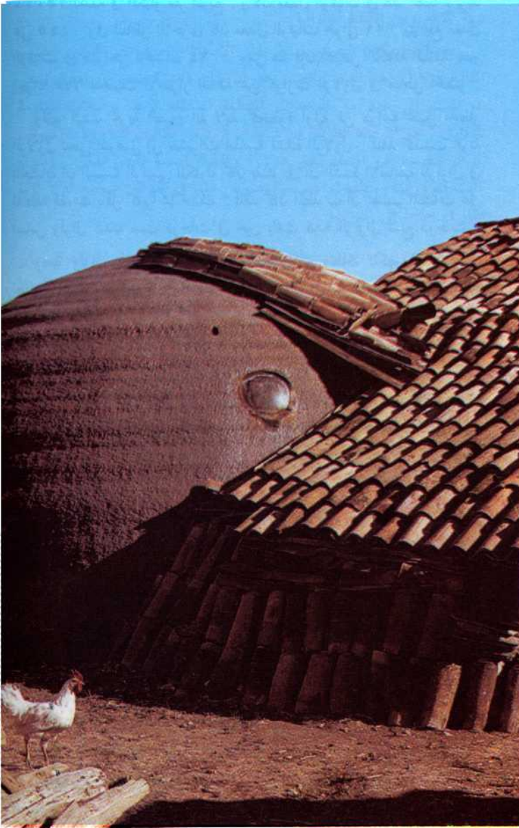
بعض الحلول المحلية التي ابتكرها السكان للربط بين أسطح القباب المقوسة بالمباني التقليدية في المنطقة .
