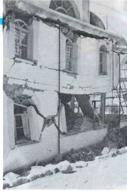
حتى إذا كان المنشأ نفسه صامد أمام الزلازل ، فقد تتعرض العناصر غير الإنشائية للانهيار مثل هذه الحوائط المبنية من الطوب والتي انهارت أثناء زلزال هاينشج ١٩٧٥ م .
