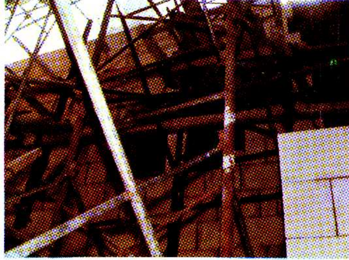
أعمال الترميم المعماري
