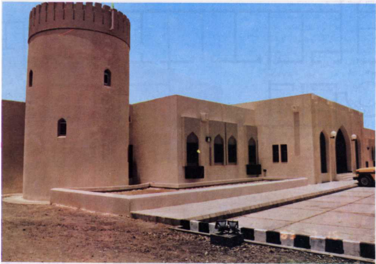
منظر عام لمبنى مكتب الوالي
