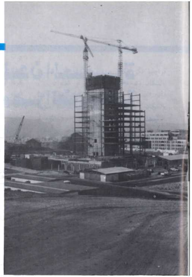
● الهيكل الحديدى المحيط بالكور الحرسانى مكوناً الأدوار المتكرره لمبنى الفندق
