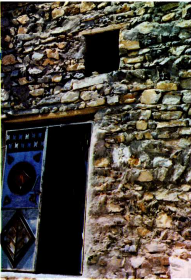
تفصيله لمدخل أحد المساكن ويلاحظ نظام البناء باستخدام قطع الحجارة
