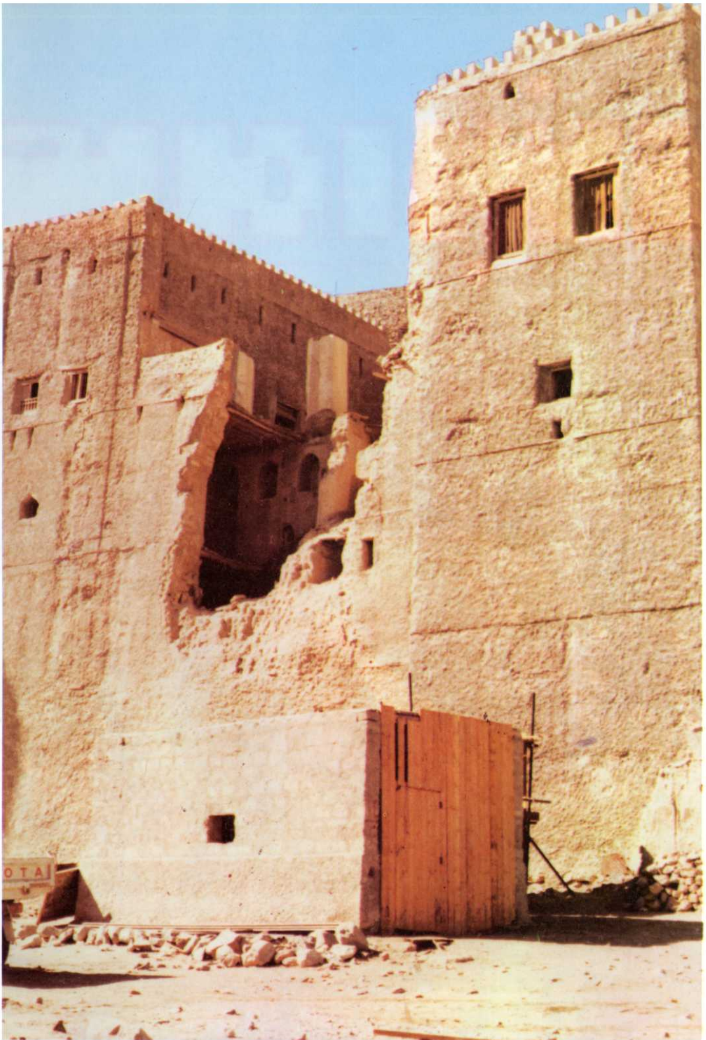
● قلعه جبرين في ندوه الواجهه الشرقية قبل الترميم
