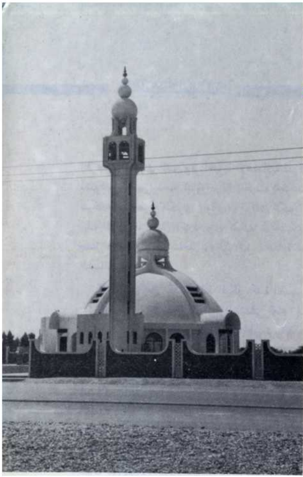
تميز المدن العمانية بالاهتمام بإنشاء المساجد .
