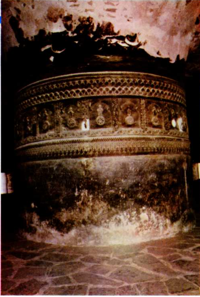
الدعامة الرئيسية التي تحمل برج المدفعية في قلعة الرستاق .
