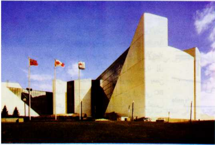
مركز حضري في سكاربورج - أونتاريو ... استخدام المسطحات الضخمة من المبانى بجانب المسطحات الزجاجية العاكسة بأسلوب التضاد بين ملمس المواد المستعملة ويضفي أسلوب الإنشاء على المبنى قوة وجمال خاص ... يعكس هذا المبنى فكرة الفصل بين الشكل الخارجى للمبنى والتشكيل الداخلى للفراغات .
