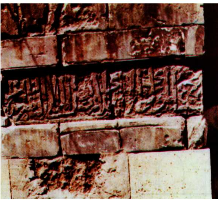
الإفريز الرخامي على يسار المدخل ( بعد الترميم )
