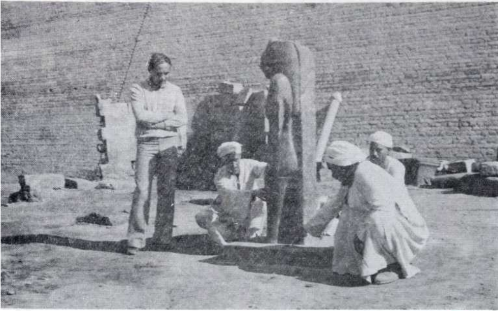
▲ تمثال الآفة « سخمت » بعد الانتهاء من رفعه وتثبيتته واقفاً وأثناء الانتهاء من بناء قاعدته . يظهر خلفه هيكل صغير لكنيسة رومانية . ويجوارها بعض القطع الحجرية الأثرية التي تم العثور عليها أثناء حفر أساسات الأهالي لمنازلهم .
