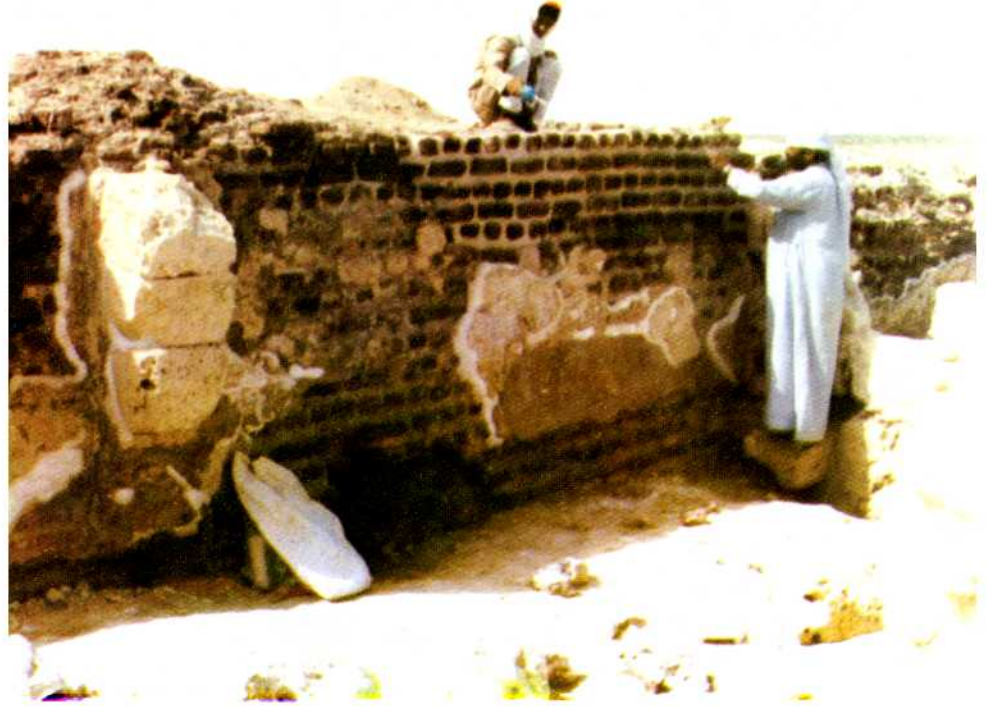
جدار من الطوب الأحمر القديم لحمام منطقة الميناء .
