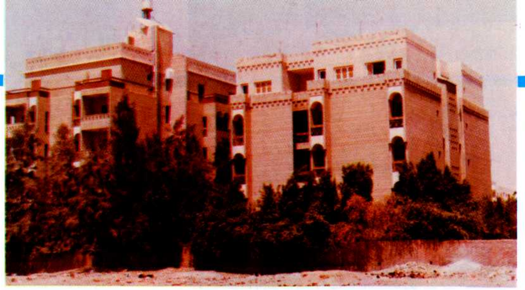
مجموعة سكنية بمدينة نصر - من أعمال مركز الدراسات التخطيطية والمعمارية .
