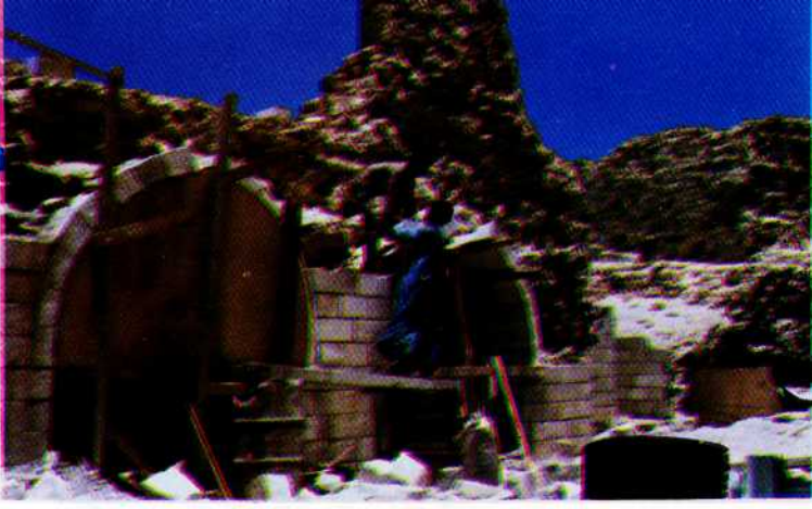
مزاغل المدافع في السور الشمالي للقلعة قبل الترميم .
