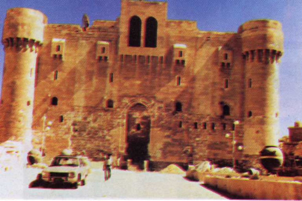
منظر عام للواجهة الجنوبية للدرج الرئيسى ( قبل الترميم ) .
