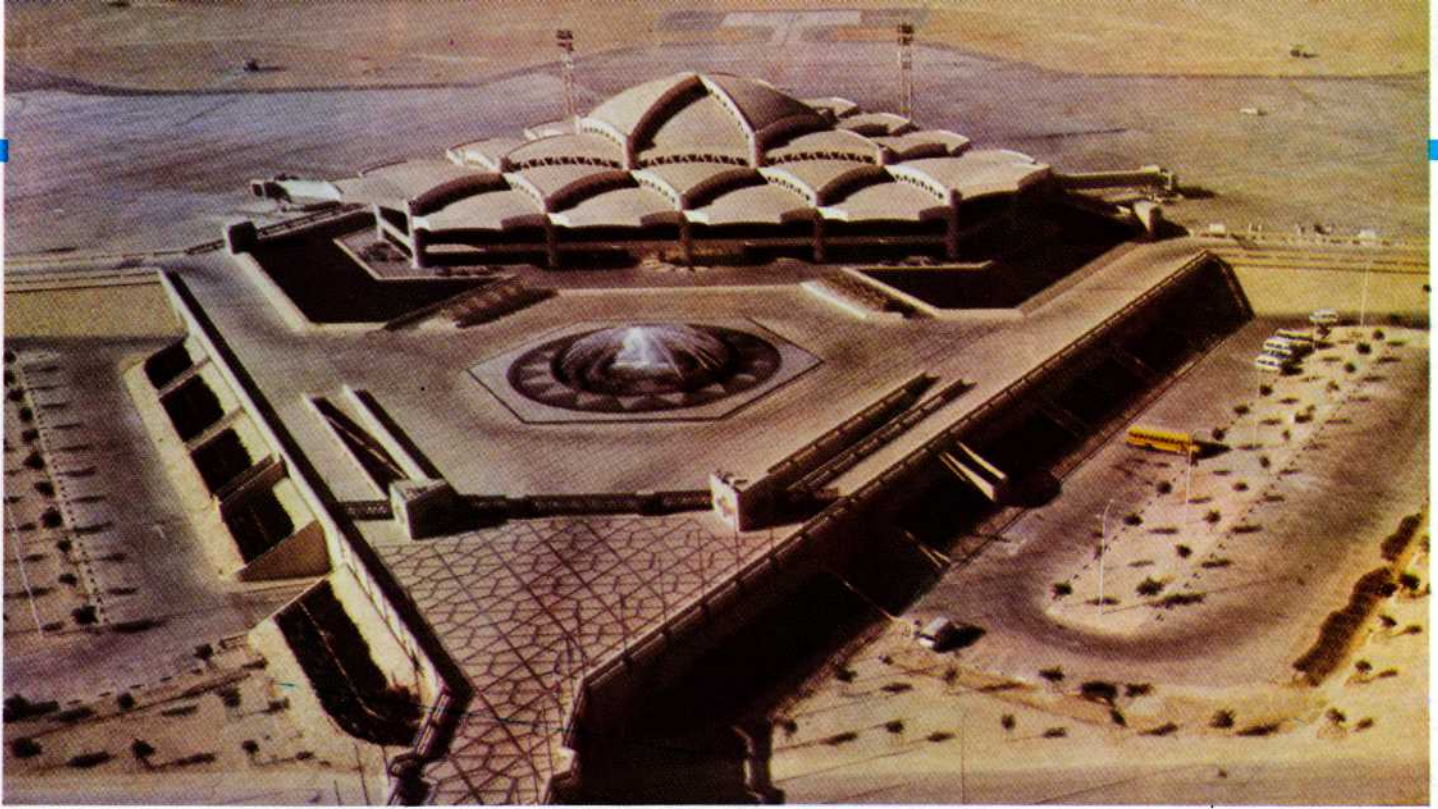
المحطة الملكية إستخدمت فيها نفس الوحدات القشرية المثلثة بتشكيل مختلف عن محطات الركاب .
