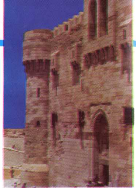
جزء من الواجهة الجنوبية ( الرئيسية ) بعد الترميم .
