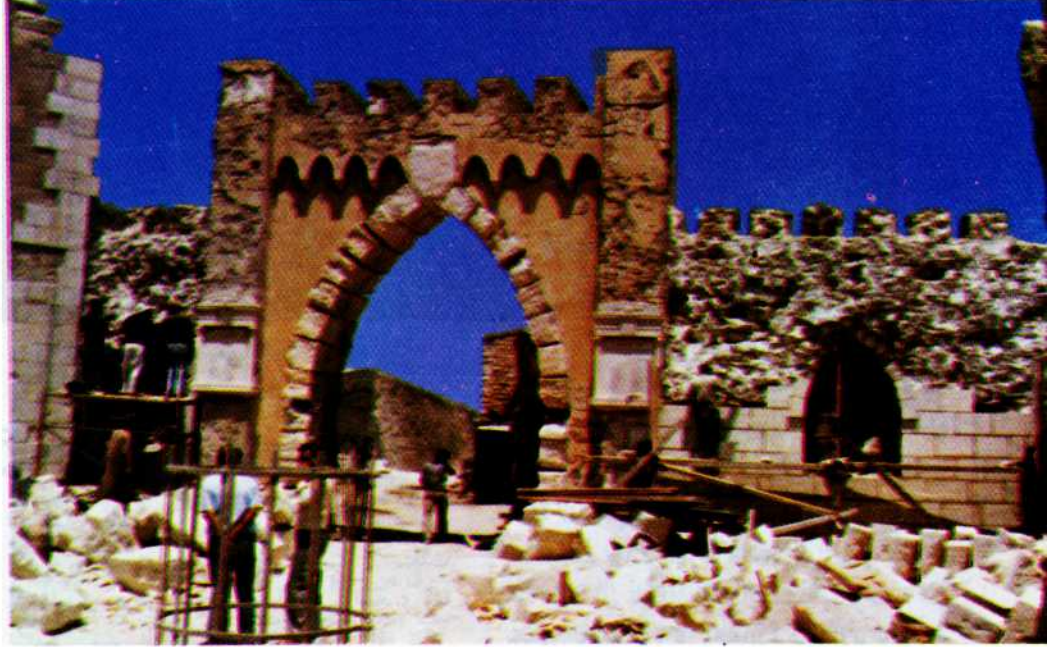
بوابة البلدية أثناء أعمال الترميم .
