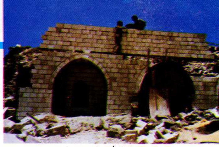
● مزاغل المدافع أثناء الترميم
