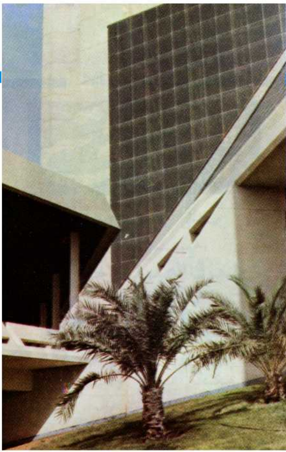
المدخل الرئيسي في المستوى العلوى الذي يصل إلى الفراغ الداخلي لفندق انتركونتيننتال - الشارقة .
