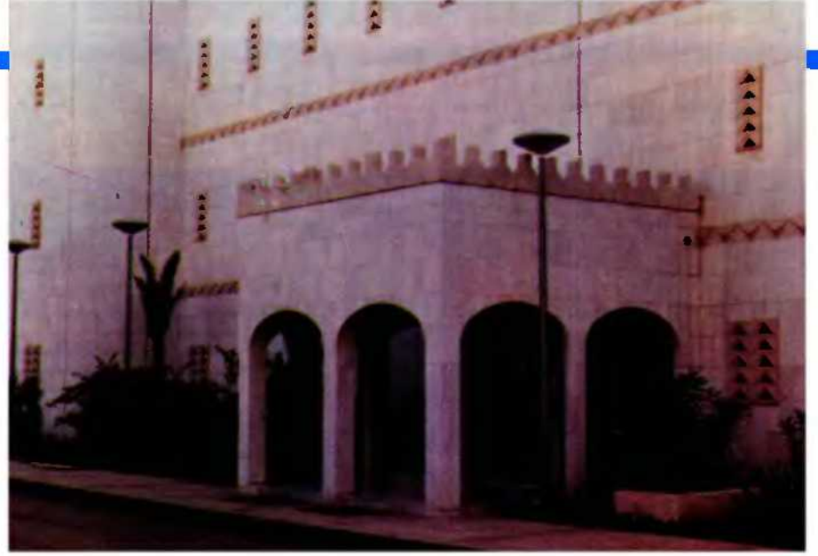
● المدخل الرئيسى لمبنى الامم المتحده بالرياض
