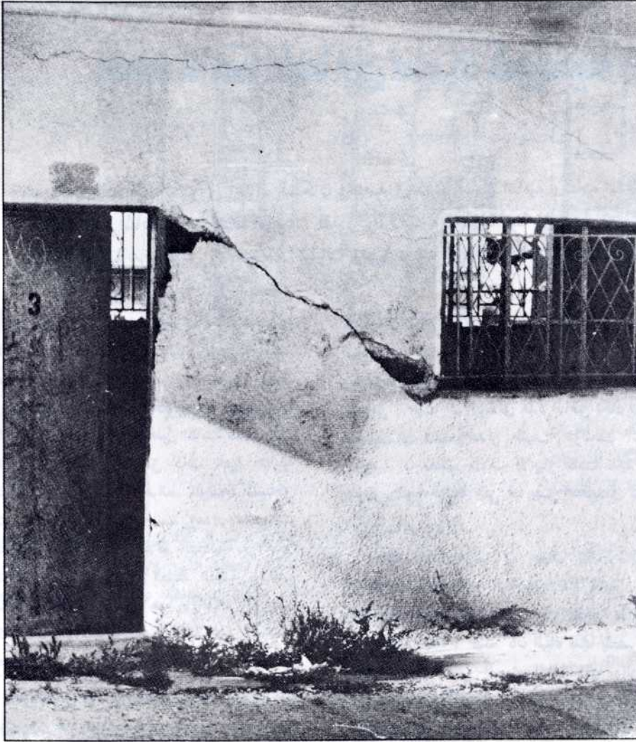
التصدع الشديد الذي أصاب إحدى المدارس في شمال الأردن . مما دعا إلى احداثها .
