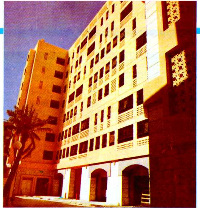
مبنى سكنى تجارى لوزارة الحج والأوقاف بالمدينة المنورة .
