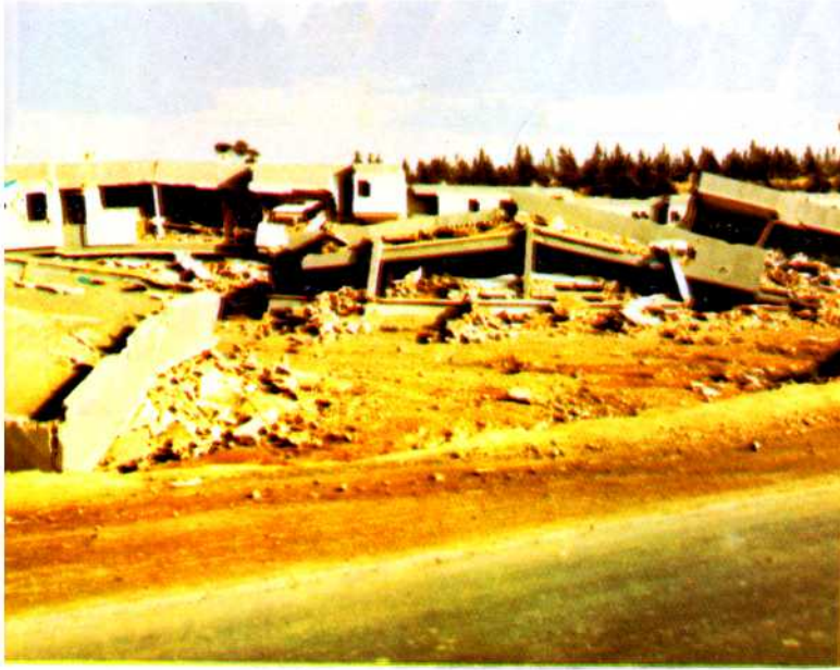
▲ مشروع ١٠٠ فيلا سكنية : أحدث الزلازل تهدماً في أغلب الوحدات نتيجة لصغر قطعاعات الأعمدة حيث كانت ٢٥×٢٥ سم ، وكذلك لسوء نوعية الخرسانة المستخدمة في البناء .
