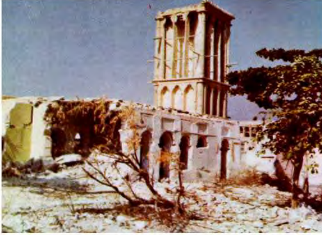
● الكشتيل ( البوجير ) .. احد العناصر المعمارية العامة المستخدمة كمكلف للهواء في مبان الشارقة
