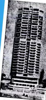
برج المعدي مجمع سكني ايجدي اشرى
