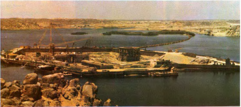
جزيرة قبله بعد أن تم تفرغ المياه من داخل السد المؤقت حوفا .
