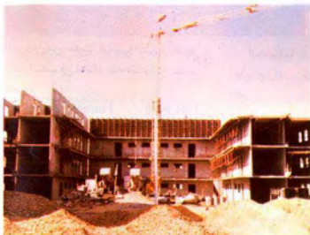
نظام التفرع المعدنيه للمحافظ والأسقف تنفذه الشركة بنجاح في مساكن مدينة السلام
