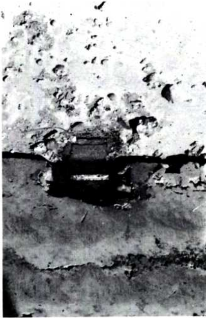
اتصال حائط حامل داخلي ببلاطه افقيه .
