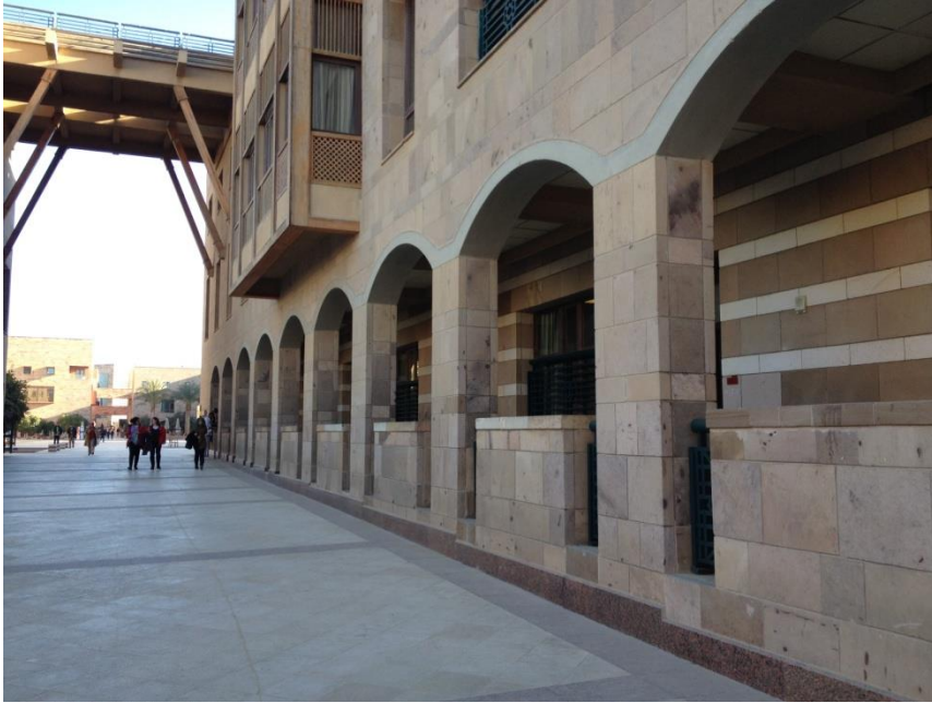
Fig. 170 AUC balconies next to SSE
