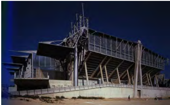
شكل رقم (١-٣٦): ٣ National Gymnastics Centre, Alicante, Spain, 1993. الإستفادة بالتطور التكنولوجي في المبنى تحت إطار إقتصادي بما يضمن إمكانية تنفيذه.
