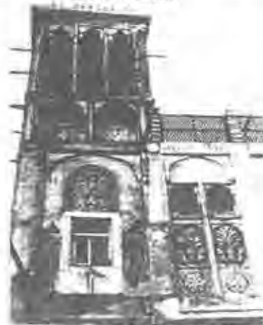
Bild 4. : Ein Windeinfänger mit Windauslaß in Kairo.
