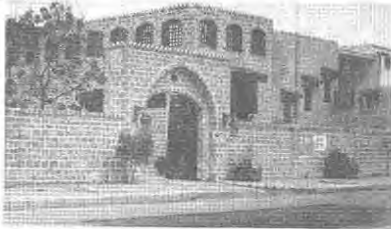
Bild 3.: Bild der Villa Nassief, Jeddah, Saudi-Arabien.
