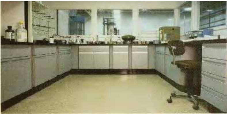
شكل (39) يوضح احد نماذج التغطية بالايبوكسى فى احد المعامل للنظائر المشعة
