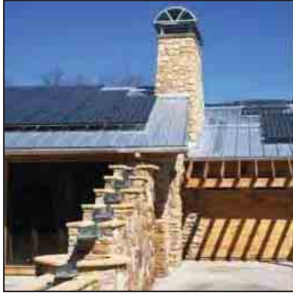
شكل (٣-٣٢) توظيف الأحجار المحلية التي تم استرجاعها وإعادة استخدامها بالموقع.
