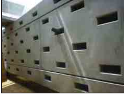
شكل (٤-١١) كسوة قاعة القراءة بيانوهات من الخرسانة المسلحة سابقة الصب.
