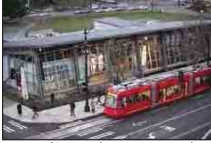
شكل (٦٣-٣) توفيق المبنى بالقرب من الشارع الرئيسي ليسهل عملية نقله فيما بعد.
