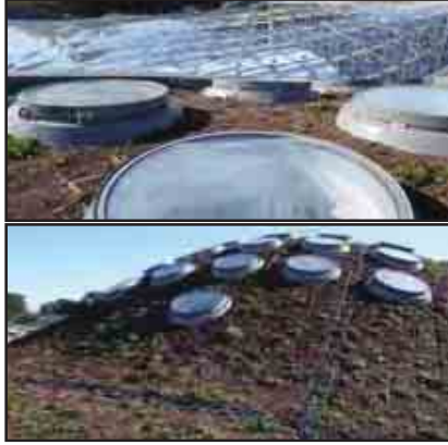
شكل (٧-٣) توظيف وحدات الإضاءة السقفية لتحقيق مستويات عالية من الإضاءة الطبيعية.
