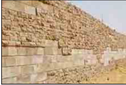
شكل (٣٢-٤) إعادة استخدام مخلفات الأحجار في تشييد حائط الخريجين Alumni all. المصدر الباحث، (٢٠٠٩).
