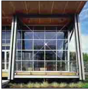
شكل (٣-٧٠) أحد الوحدات الموديولية الأربعة التي يتكون منها هيكل المركز.
