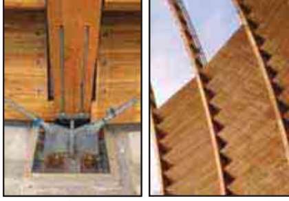
شكل (٣-٤٣) تفصيلة تدعيم الهيكل الإنشائي الخشبي بوصلات من الحديد الصلب.
