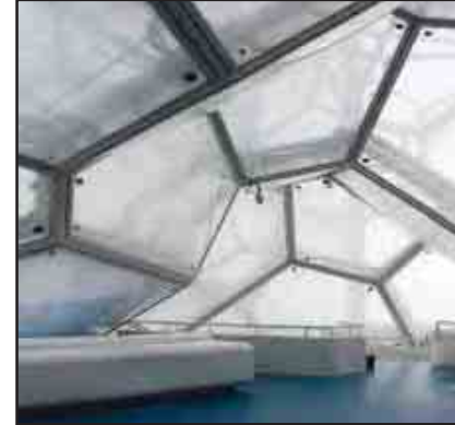
شكل (٣- ١٦) التكوين الفريد للوحدات متعددة السطوح من الحديد الصلب واللدائن. Source: http://www.e-architect.co.uk/beijing/watercube_beijing.htm , Accessed (1/3/2009).
