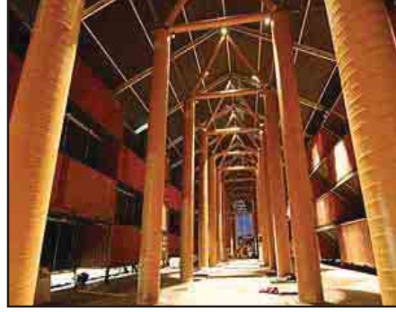
شكل (٢٥-١) استخدام مواد البناء المعاد تدويرها كالأنابيب الورقية بالمتحف البدوي بنيويورك الأمريكية.
