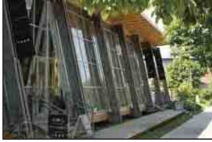
شكل (٣-٦٩) قطاعات الحديد الصلب سابقة التجهيز المستخدمة في تكوين الأعمدة.
