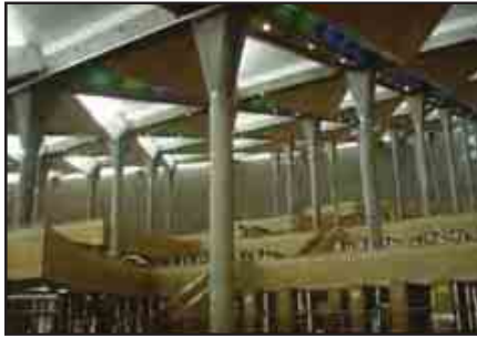
شكل (٤-١٣) توظيف الأعمدة الدائرية ذات التيجان الهرمية الشكل في الهيكل الإنشائي. المصدر الباحث، (٢٠٠٩).
