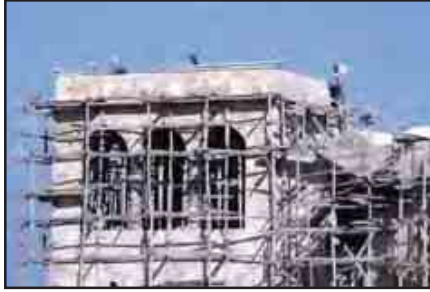
شكل (٤-٥٤) يوضح أعمال البناء الحوائط والكسوات باستخدام الأحجار الهاشمة. Source: Aga Khan, (2004).
