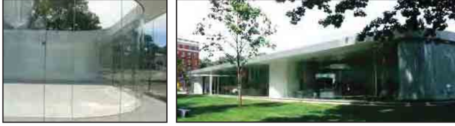
شكل (٢-٢٣) استخدام الزجاج في عمل القواطع بالمعرض الزجاجي - للمعماري SANAA Source: http://www.arcspace.com/architects/sejima_nishizawa/glass1,Accessed(1/11/2008)
