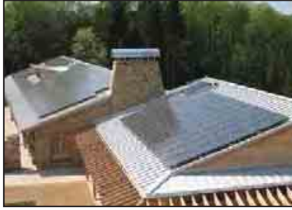
شكل (٣-٣١) تثبيت الخلايا الشمسية المولدة للطاقة الكهربائية بالأسقف.
