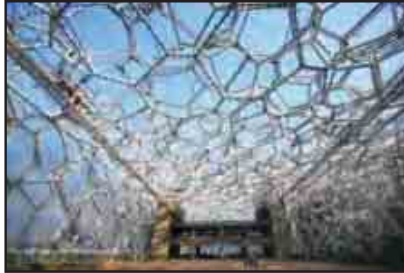
شكل (٣-١٩) الهيكل الإنشائي الضخم من الإطارات الفراغية يشمل الحوائط والأسقف من الحديد الصلب أثناء التنفيذ.
