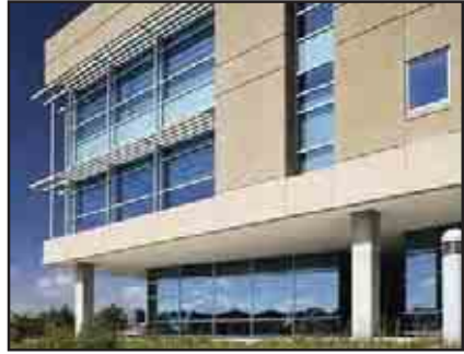
شكل (٧٧-٣) الكسوات الخارجية من البانوهات الخرسانية سابقة التجهيز.
