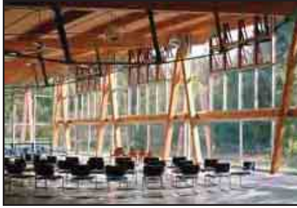
شكل (٣-٥٨) تدعيم الكمرات الخشبية بوصلات من الحديد الصلب.
