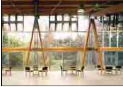
شكل (٣-٥٧) استخدام الأعمدة من الأخشاب الشرائحية مزدوجة الشكل.
