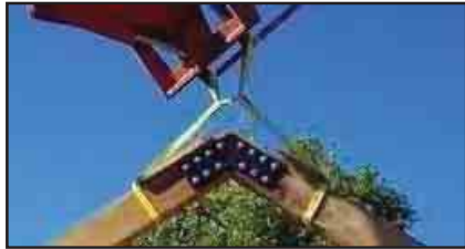
شكل (٣-٣٧) أحد الوصلات المعدنية من الحديد الصلب المستخدمة في تثبيت الأسقف. Source: http://www.aldoleopold.org/legacycenter , Accessed (1/3/2009).
