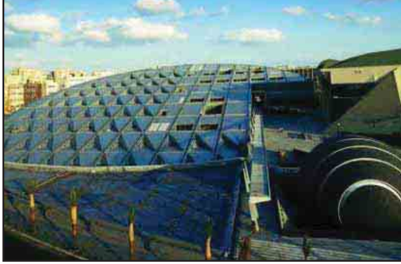
شكل (٤-٣) لقطة لمبنى مكتبة الإسكندرية والقبة السماوية من جهة البحر.
