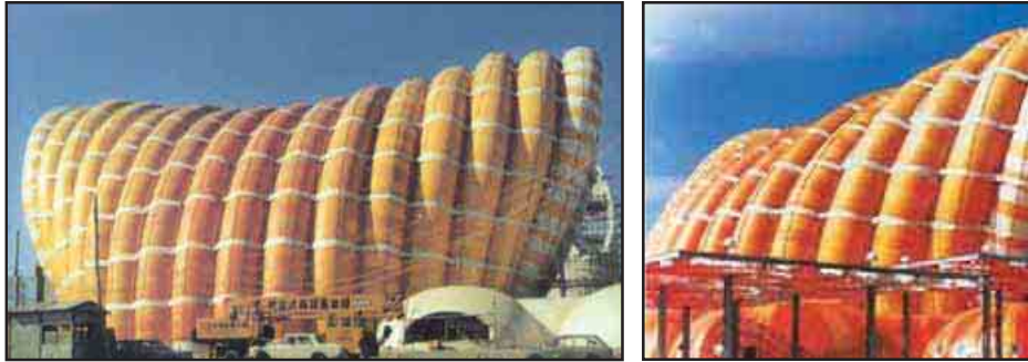
شكل (٢-٢٦) استخدام اللدائن في المنشآت المنفوخة - معرض فوجي باليابان Fu i Group Pavilion Source: http://www.tensinet.com/database/viewProject/3765 , Accessed (1/11/2008)
