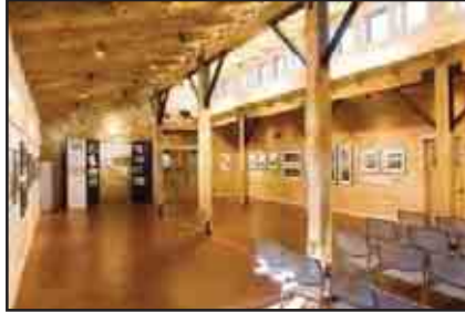
شكل (٣-٣٥) الأعمدة من أخشاب الصنوبر المحلية واستخدام الوصلات المعدنية.
