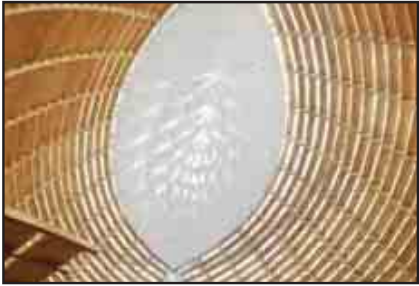
شكل (٤٨-٣) تغطية السقف البيضاوي Ocular Ceiling من الداخل بشرائح من الألمونيوم. Source: http://www.som.com/cathedral_of_christ_the_light , Accessed (1/2/2009).
