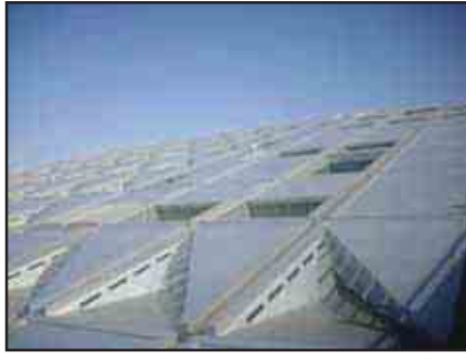
شكل (٤-١٤) تغطية سقف المكتبة بوحدات هرمية الشكل و قد كسيت بألواح الألمونيوم من الخارج.
