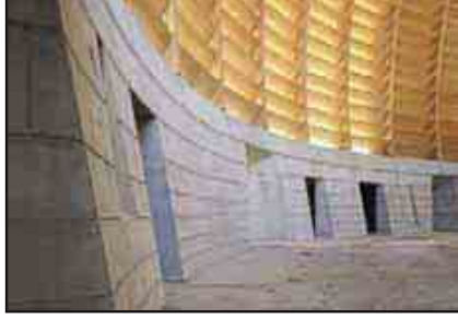
شكل (٤٦-٣) استخدام الحوائط من الخرسانة المسلحة وتركها علي طبيعتها بدون دهان.
