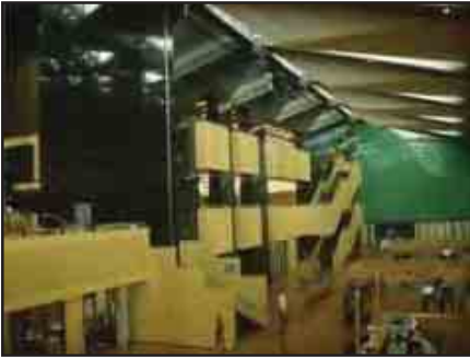
شكل (٤-١٥) كسوة الحوائط الخرسانية الإنشائية بالأخشاب الطبيعية وألواح الجرانيت
