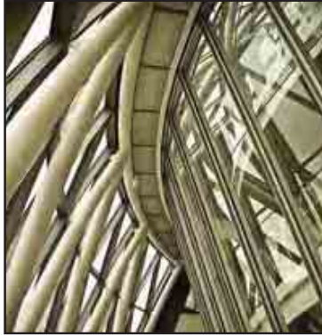
شكل (٣- ٢٨) الهيكل الإنشائي الخارجي من العناصر الدائرية من الحديد الصلب Geodesic lattice
