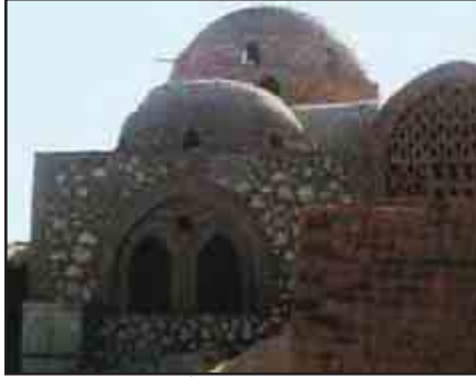
شكل (٤-٤٠) توظيف الأحجار الجيرية المحلية في تكوين الحوائط الرئيسية السميكة. Source: AKTC, (2008), "Al-Fustat Ceramics Center "
