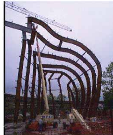
شكل : ٢-٤٤ : الهيكل الإنشائي لمشروع الإحساس بالموسيقى، والذي استخدمت طرق التقطيع الثاني والثالثي الأبعاد، في تنفيذه.
