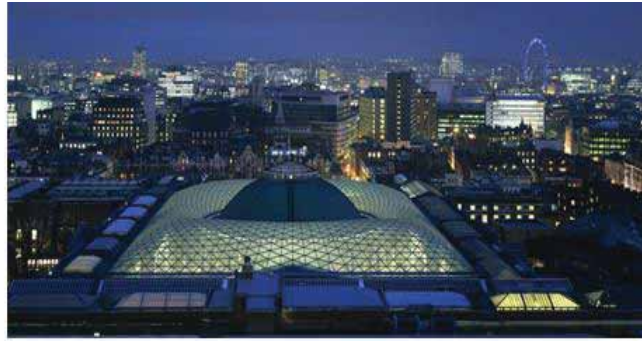
شكل: ١٦-٣ مشروع Great Court ، لندن ، المملكة المتحدة ، للمعماري نورمان فوستر المصدر: .Abel, Chris. ARCHITECTURE, TECHNOLOGY AND PROCESS. Oxford: Architectural Press, 2004.
