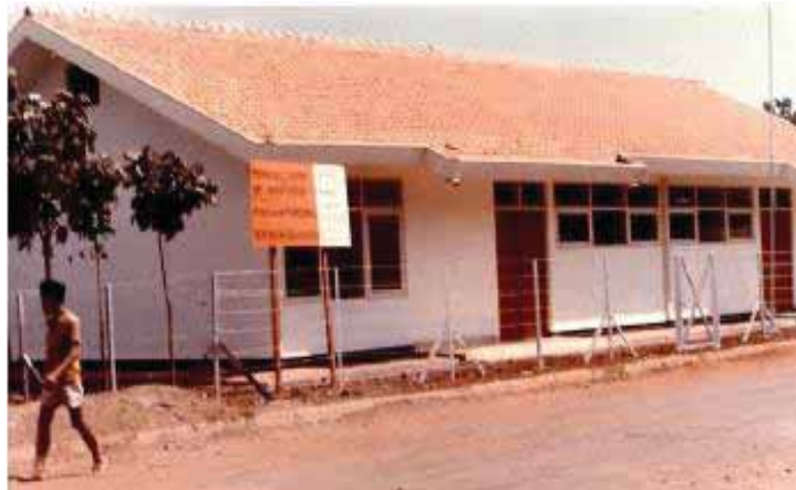
شكل ٣١-٥: يوضح مبني الوحدة الصحية المصدر: ٢٠٠٤، Kampung Improvement Program
