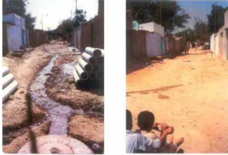
شكل ٥-٢٠: يوضح تحسن المنطقة بعد مد شبكة الصرف الصحي المصدر: the expansion of work beyond Orangi and the mapping of informal settlements and infrastructure, ٢٠١١
