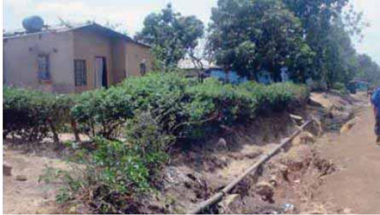
شكل ٥-٢٦: يوضح سوء حالة الطرق وشبكة المياه بعد مرور سنوات على المشروع المصدر: ٢٠٠٧، Zambia, Lusaka Urban Profile
