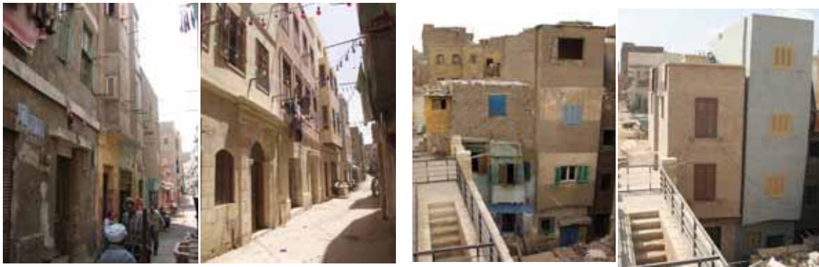
شكل ٦-٧: يوضح مشروع إعادة تأهيل المباني بالدرب الأحمر المصدر: تنمية الدرب الأحمر، ٢٠٠٨م.
