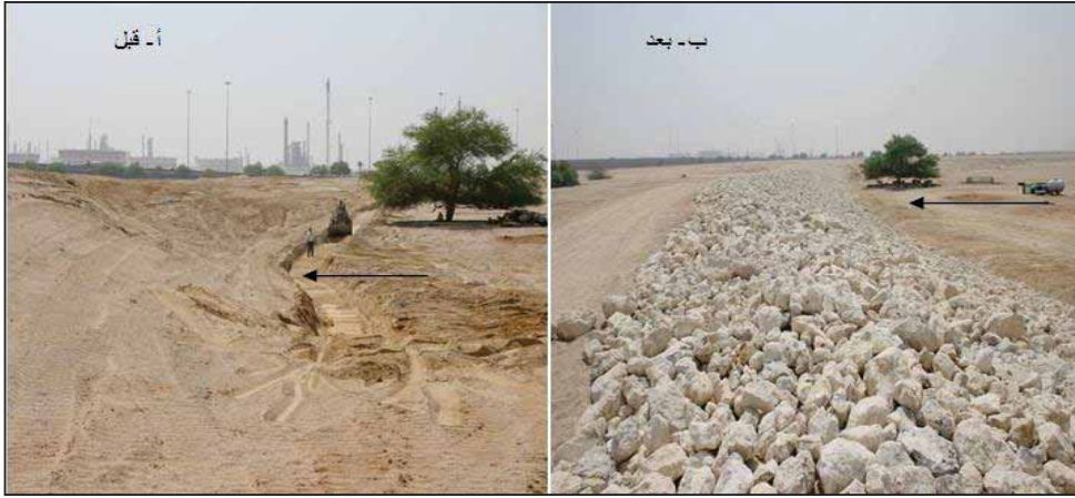
شكل (٣٢) أحد السدود بعد وقبل تدعيمه بالحجر الدبش (٢٤)
