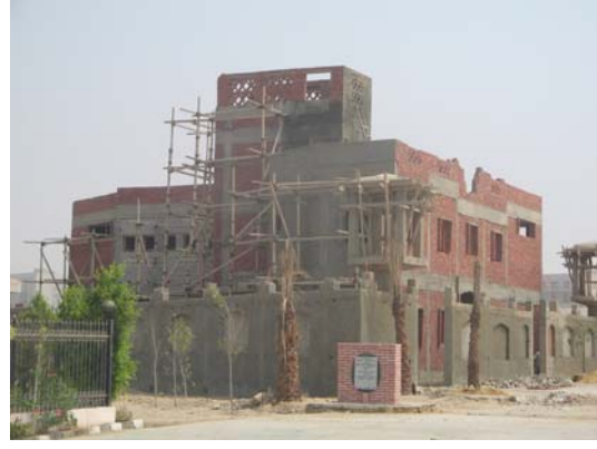
مركز الشرطة - المصدر : الباحثة .
