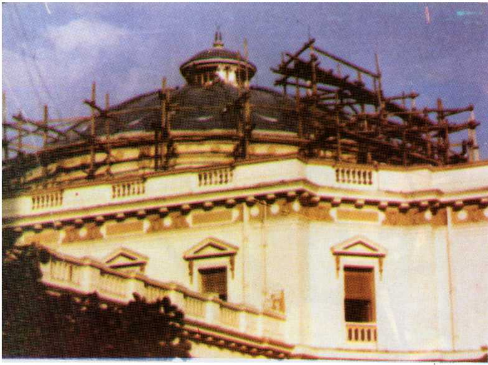
إحدى مراحل ترميم القبة من الخارج .
