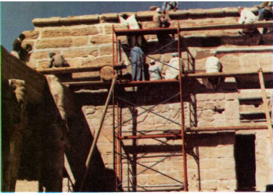
• أعمال الترميم بالصرح الثانى
