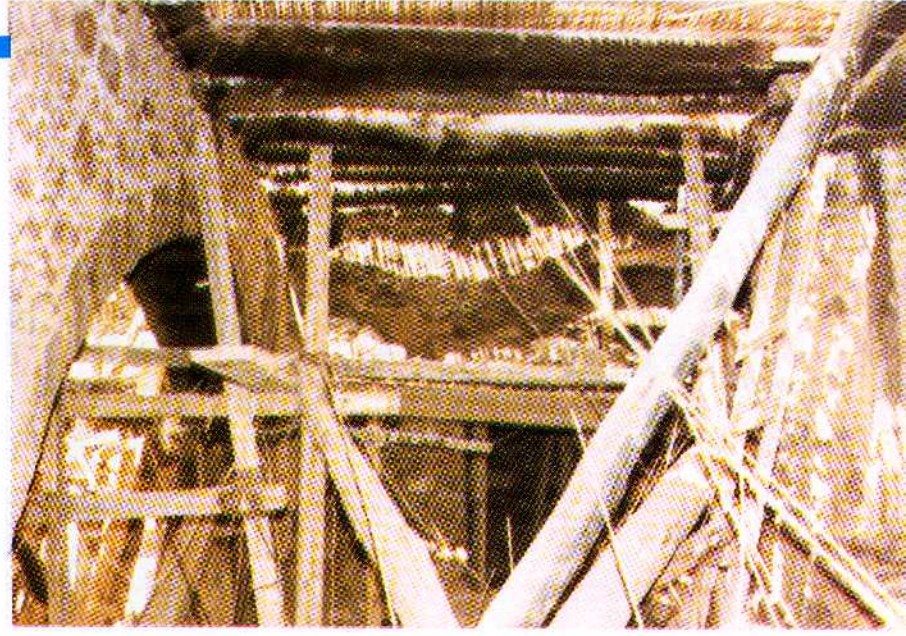
● المعصرة أثناء الترميم
