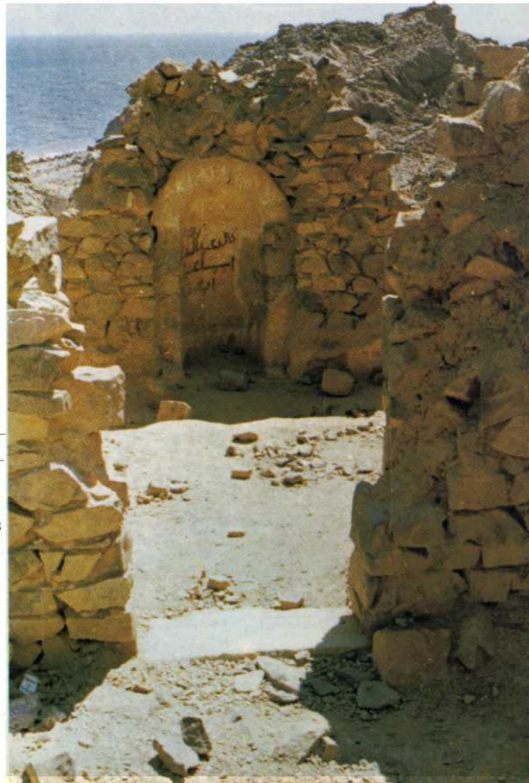
منظر عام لجامع القلعة قبل الترميم . ويظهر فيه الخراب قبل الترميم
