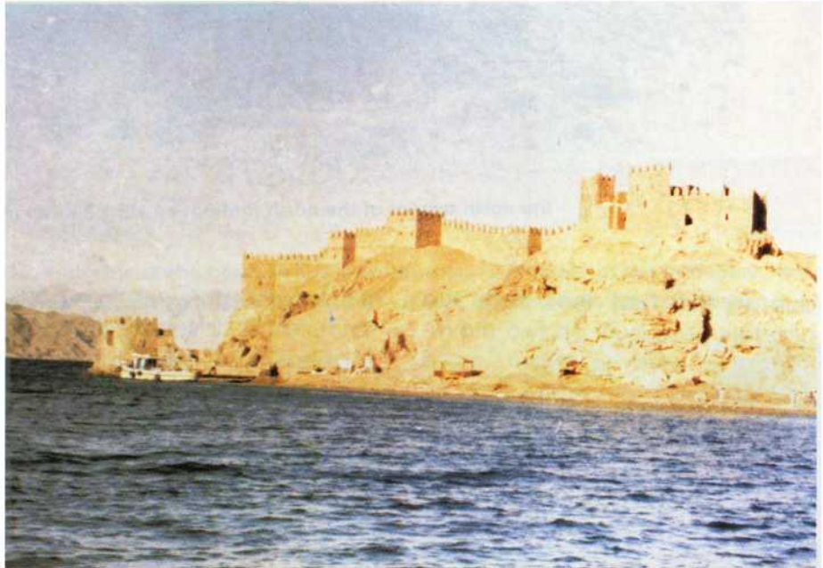
منظر عام للجزء الجنوبى من التحصين الشمالى بعد الترميم .
