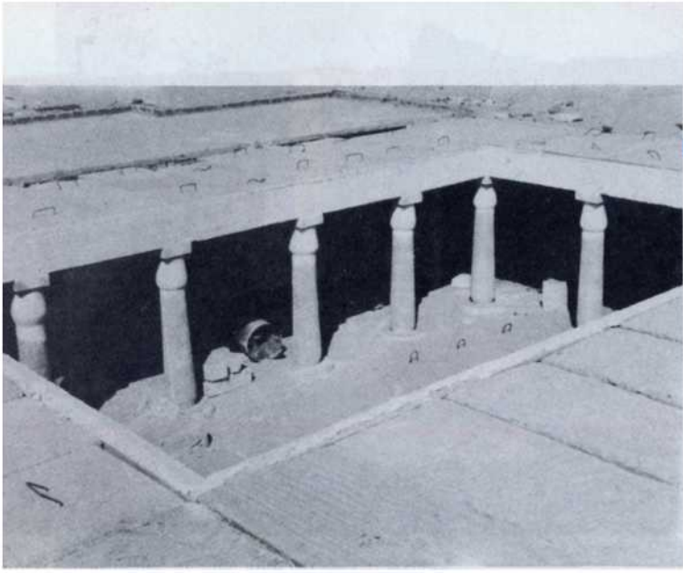
صالة الاعمدة بعد الترميم
