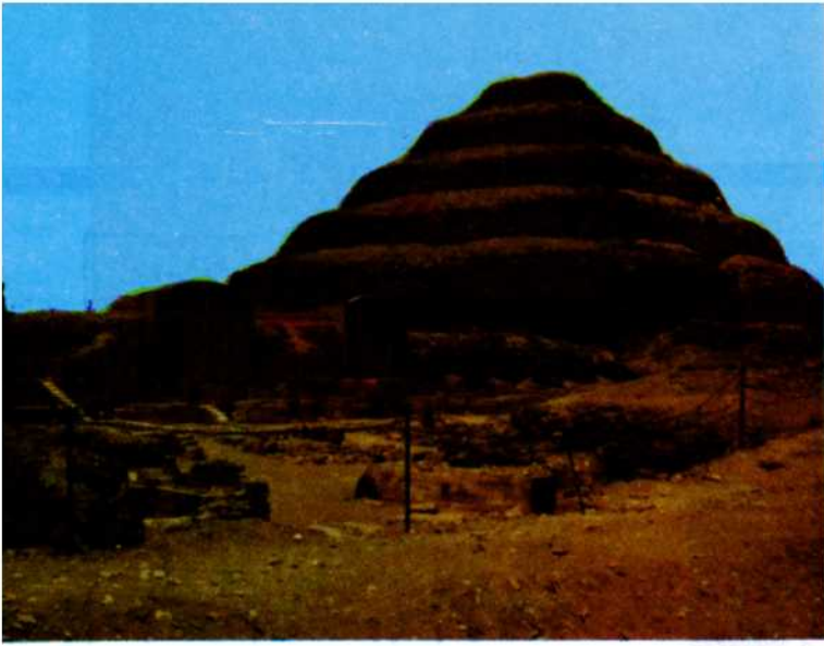
أعمال الترميم التي تجرى ببناء الإحتفالات بمجموعة زوسر .
