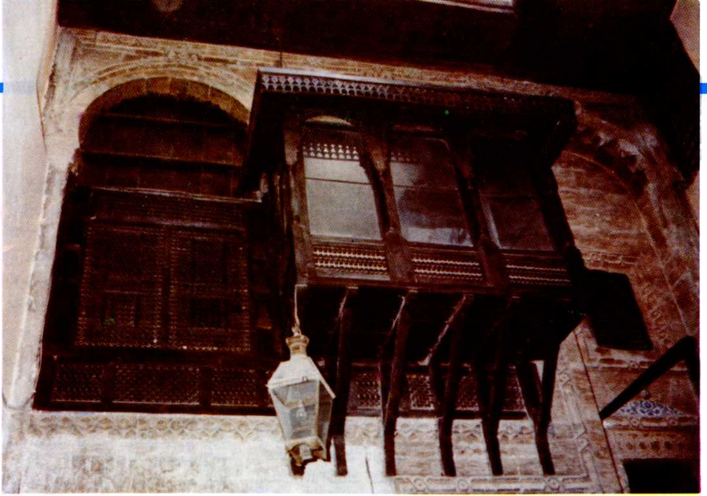
شكل المشربيات بمنزل علي لبيب ( بعد الترميم ) .
