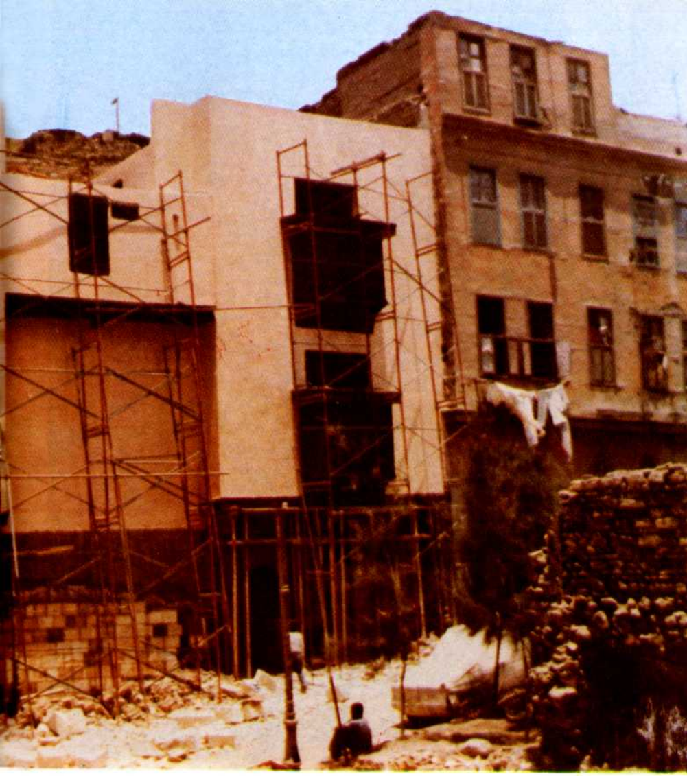
الواجهة الجنوبية الشرقية ( الرئيسية ) منزل على ليبيا أثناء الترميم .
