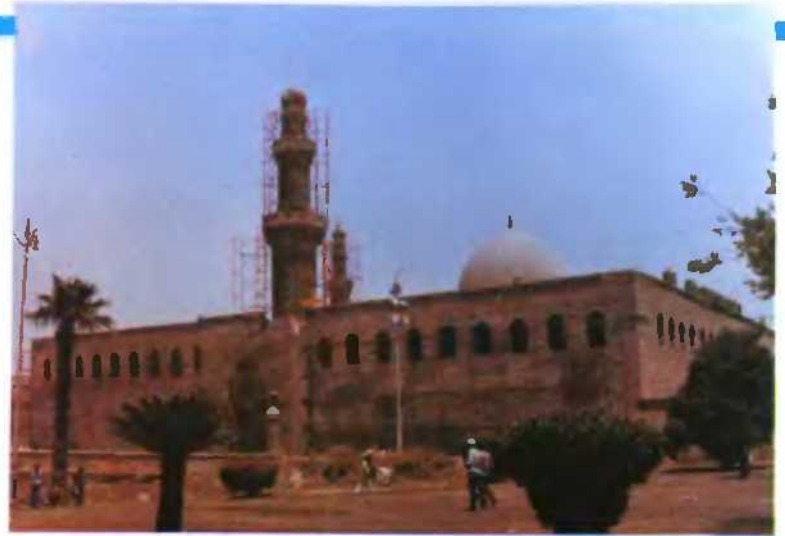
● الواجهة الغربية لمسجد الناصر محمد أثناء الترميم
