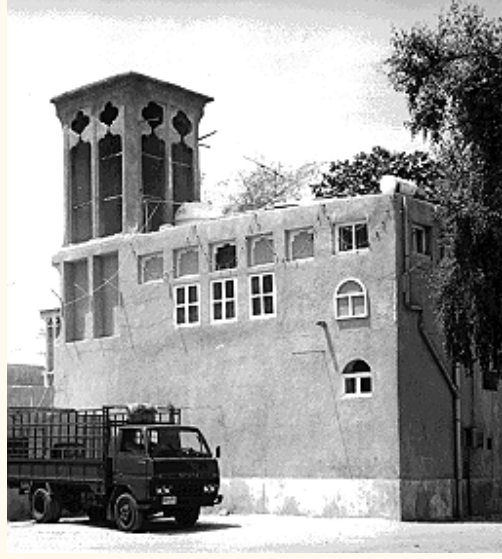
اضافة الفتحات المستعارة و فتحات التكييف للمباني التراثية بحى البستكية
