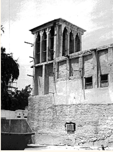
اضافة الفتحات المستعارة و فتحات التكييف للمباني التراثية بحى البستكية
