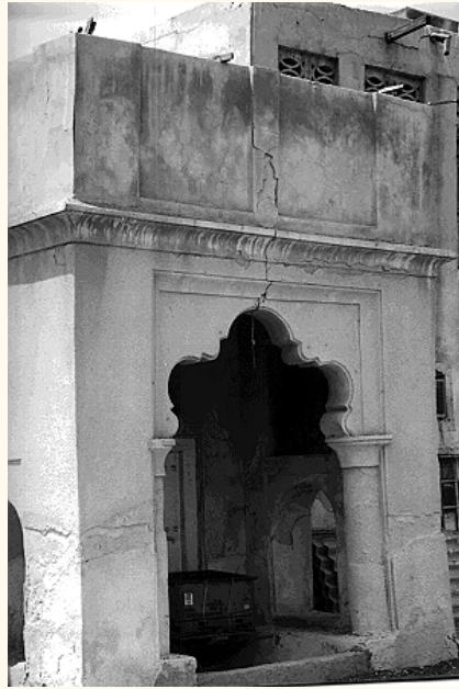
التدهور الانشائي للمدخل التراثى بحى البستكية
