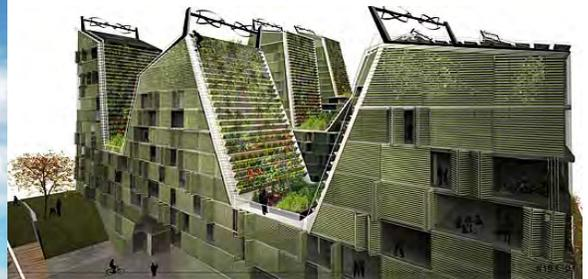
شكل (6) زراعة الأسطح وإستخدام توربينات الهواء
