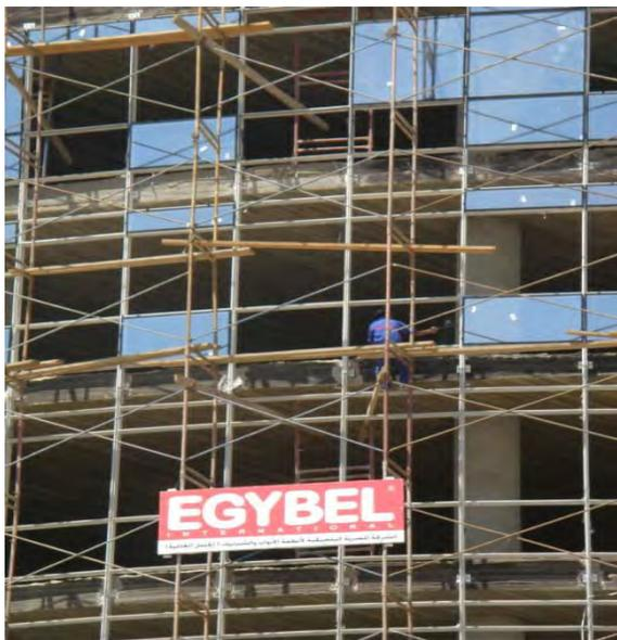
شكل(26)يتم تركيب الواجهات الزجاجية مباشرة على الخرسانة دون وجود عازل مناسب(صوف زجاجي)، مما يضاعف من نقل الحمل الحرارى داخل المبنى وبالتالي إستخدام تكييف بطاقة أعلى.
