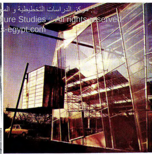
تفاصيل المبنى من الخارج
