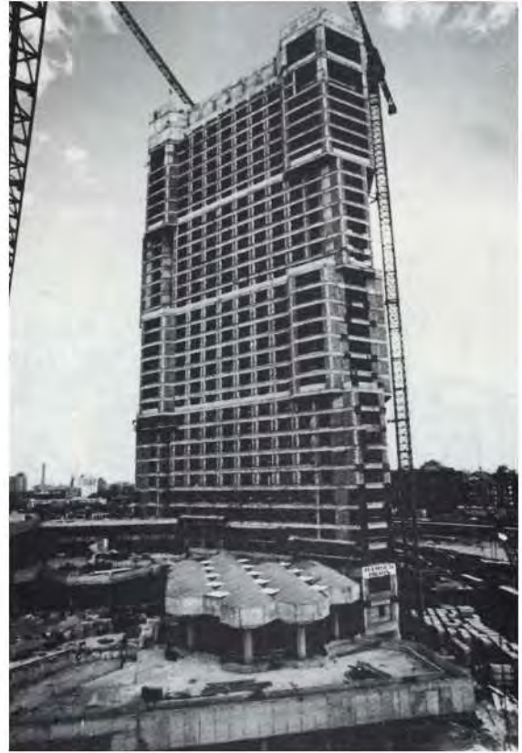
المبنى وصالات المداخل أثناء التشييد
